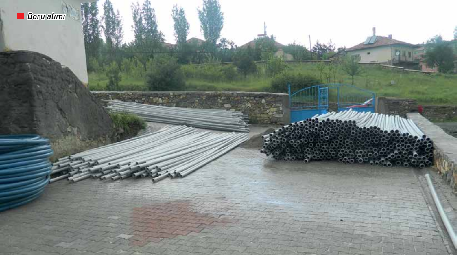
■ Su deposu yapımı
