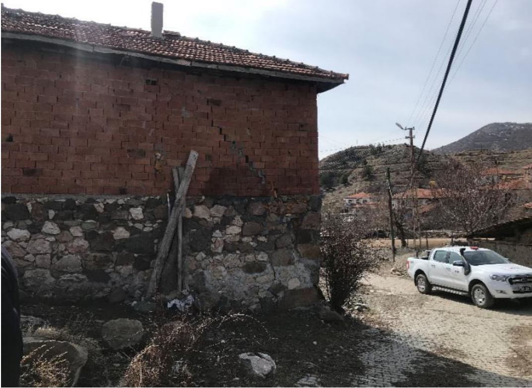
Şekil 2.18: Heyalan sonucu evde oluşmuş hasarı gösterir fotoğraf (Kaynak: AFAD Arşivleri)
